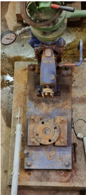
Pumpensockel vorbereitet
